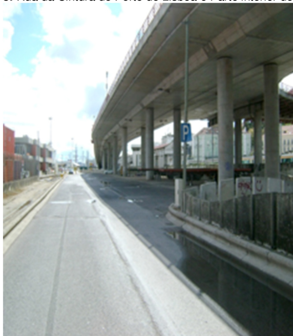
Figura 8: Rua da Cintura do Porto de Lisboa e Parte interior do viaduto.
