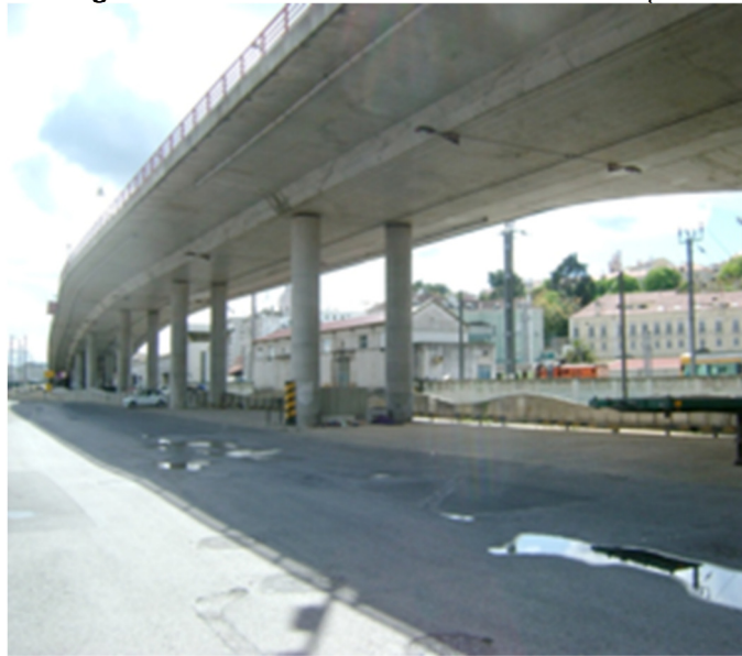
Figura 9: Viaduto da Avenida Infante Dom Henrique.
