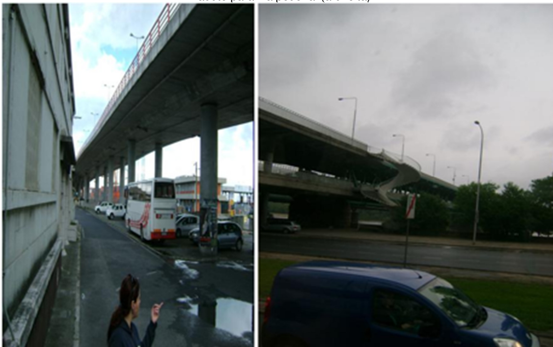
Figura 4: Viaduto da Avenida Infante Dom Henrique (à esquerda). Exemplo de via de acesso de um viaduto para via pedonal (à direita)
