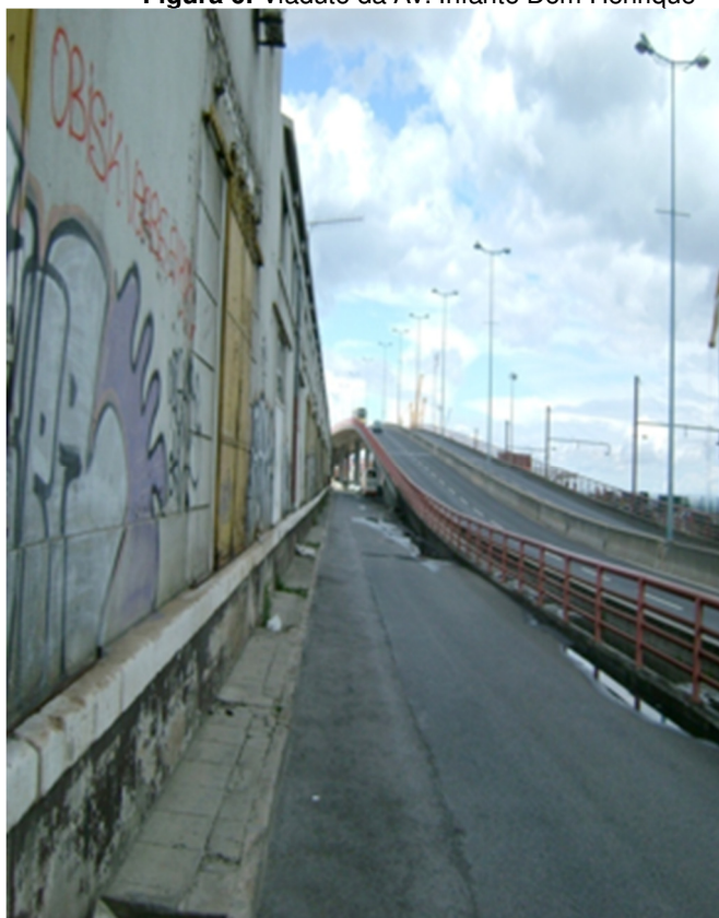
Figura 6: Viaduto da Av. Infante Dom Henrique
