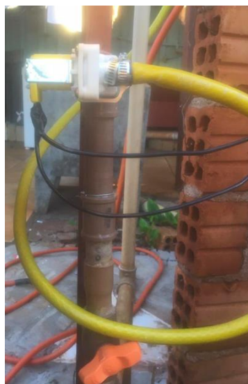
Figura 5 - Válvula solenoide
