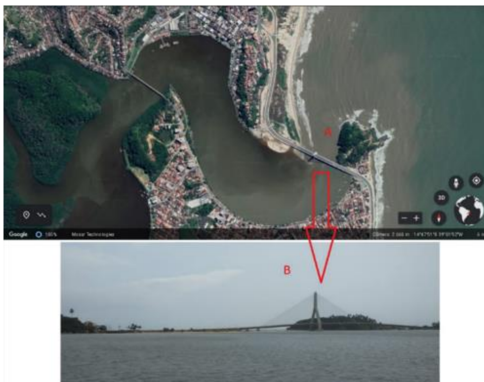
Figura 3: Ponte estaiada Jorge Amado, Ilhéus (2022)
