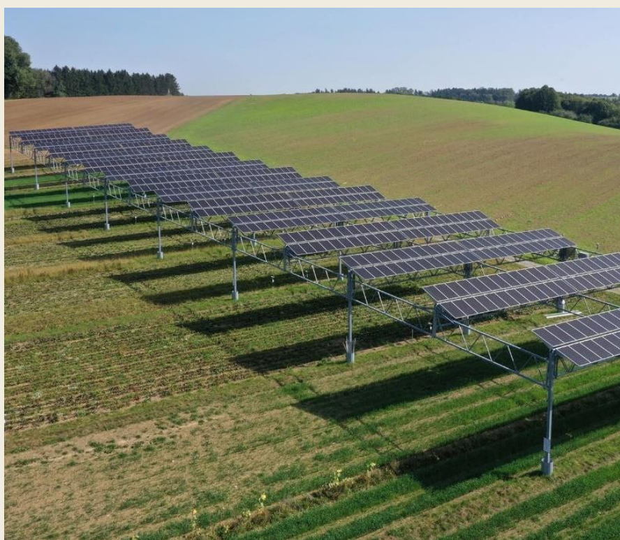
Figura 1 – Implantação de Sistema Agrivoltaico em área agrícolas
