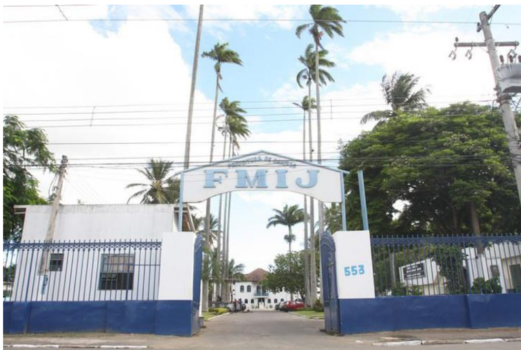
Figura 1: Faixada da Fundação Municipal da Infância e Juventude
