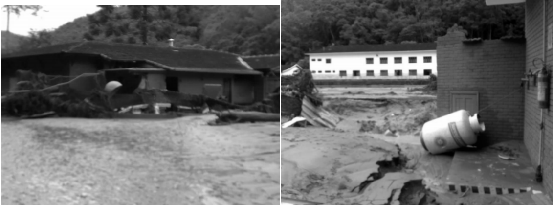
Fig. 2. Fábrica destruída pela enchente de 2011 no Vale do Cuiabá.
